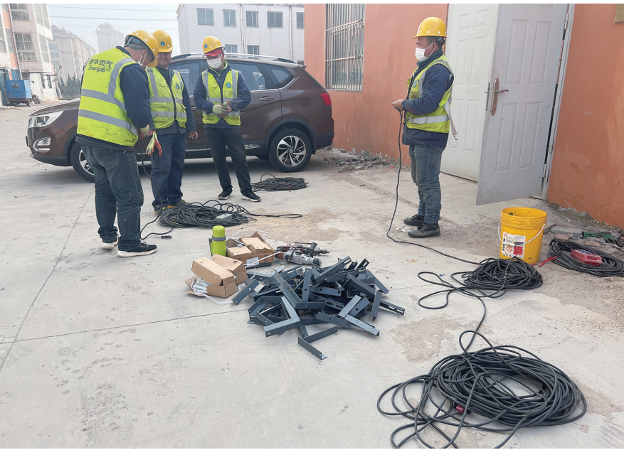
玫瑰园小区燃气入户工程现场。本报记者 曲黎悦 摄
