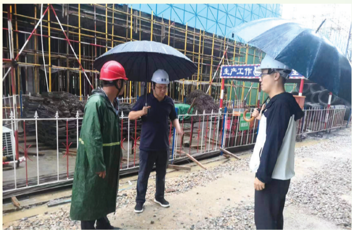
区建设局工作人员正在建设工地查看防汛情况。
