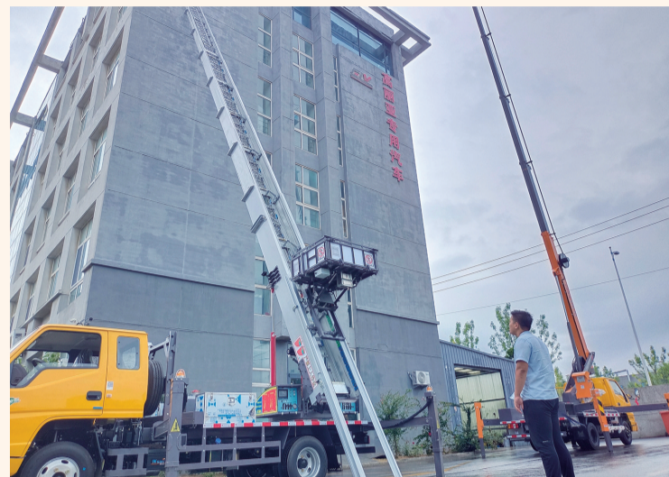
调试人员正在进行云梯车测试工作。
