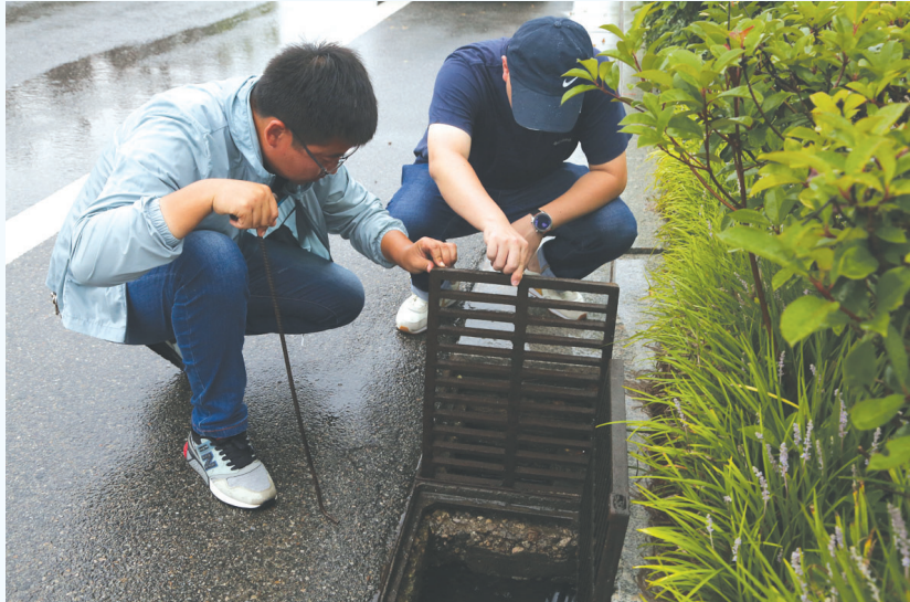
防汛小分队正在巡查。
